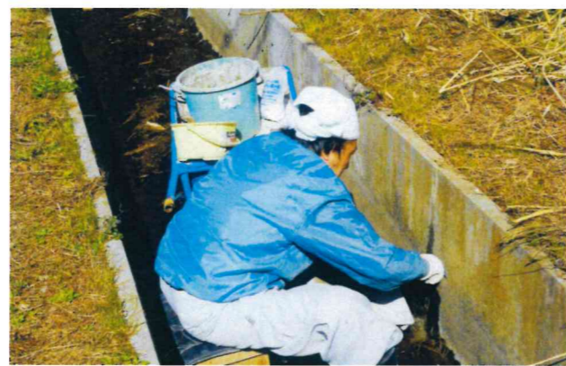
▲ 水路目地入れ作業
