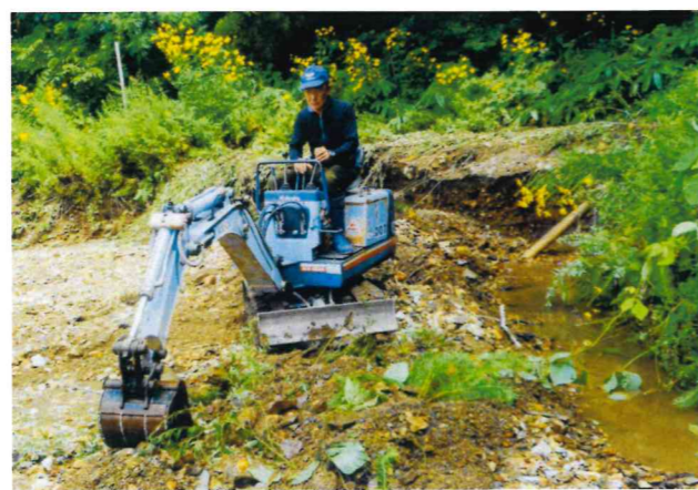
◀ 水沢水路土砂上げ
