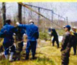
地域住民による柵の補修
