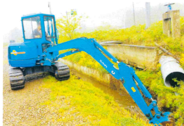
▲ 水路泥上げ作業
