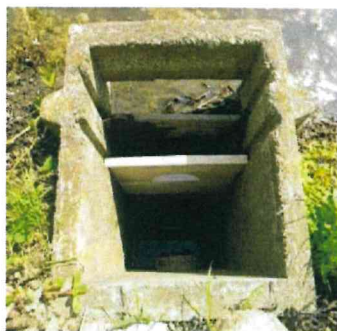
流出を抑制する落水量調整装置の例
