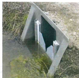
流出を抑制する落水量調整装置の例
